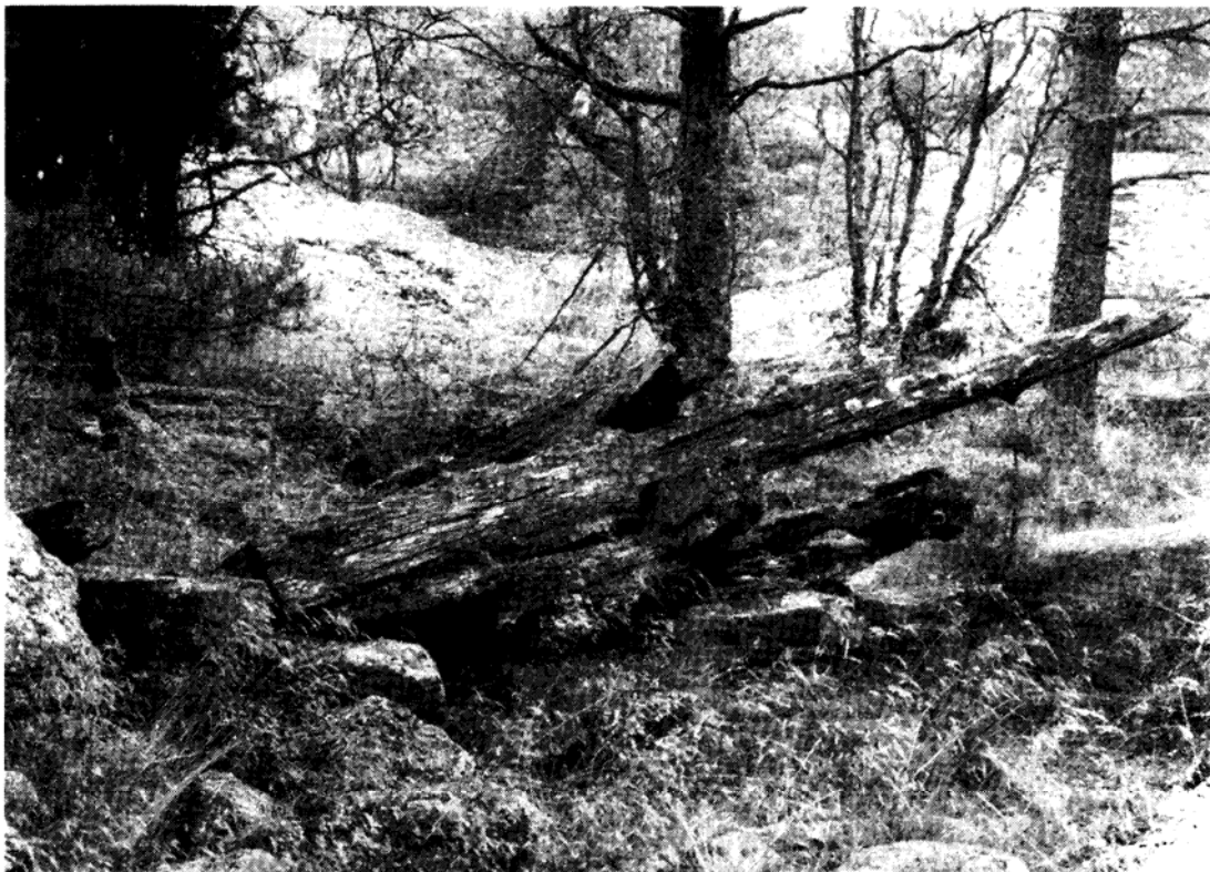
Husgrund. De nedersta timmervarven på det knuttimrade visthuset finns fortfarande kvar.
