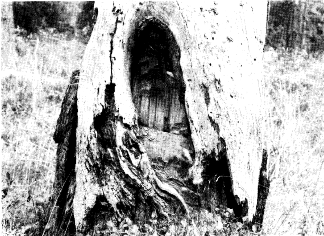
Övervallat riktskär. Fällningsarbetet har avbrutits av okänd anledning.
