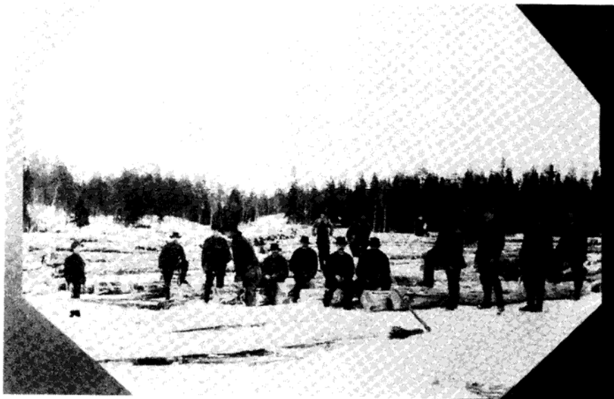
Timmertumning vid Flovallen. De första decennierna efter storskiftet genomfördes stora avverkningar i Särna-Idre skogarna. Tid: 1910. Foto: (Särna fornminnesförening).
