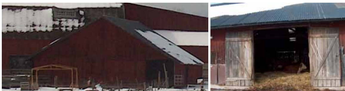
Figur 10. Ligghallen var en separat byggnad. På den högra bilden visas en av de två öppningarna.
