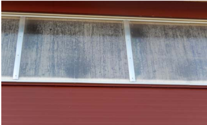
Figur 11. Rikligt med kondens på fönster i ridhus sett utifrån. Foto: Ulrika Hansson.
