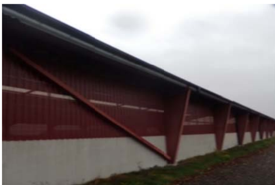
Figur 9. Ridhus med perforerade plåtväggar sett utifrån. Foto: Ulrika Hansson.
