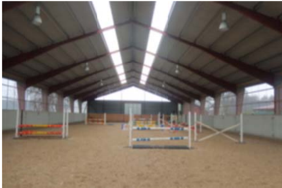
Figur 10. Ridhus med perforerade plåtväggar sett inifrån. Foto: Ulrika Hansson.
