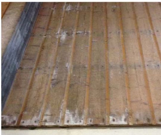
Figur 2. Exempel på fuktskadad träpanel i ridhus. Foto: Ulrika Hansson
