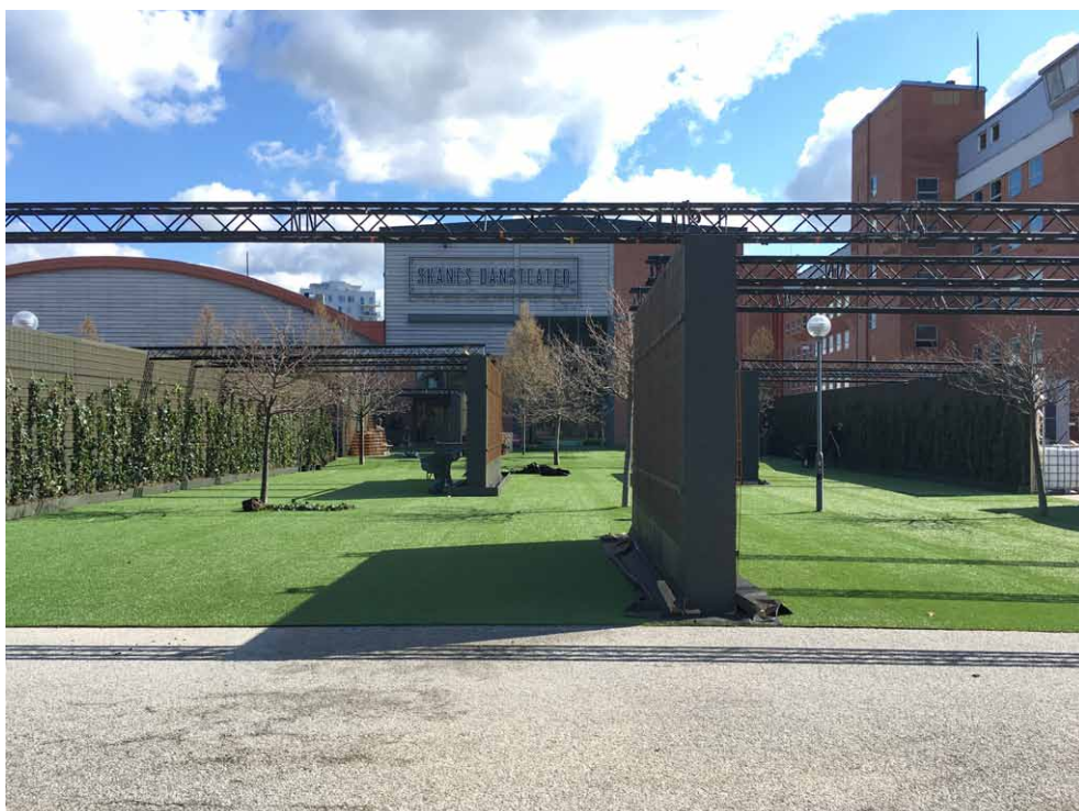
Figur 35. Trädgården 2017-04-19. Nu är alla väggelement byggda och målade. Delar av taken har kommit på plats, precis som murgrönan intill ytterväggarna.
