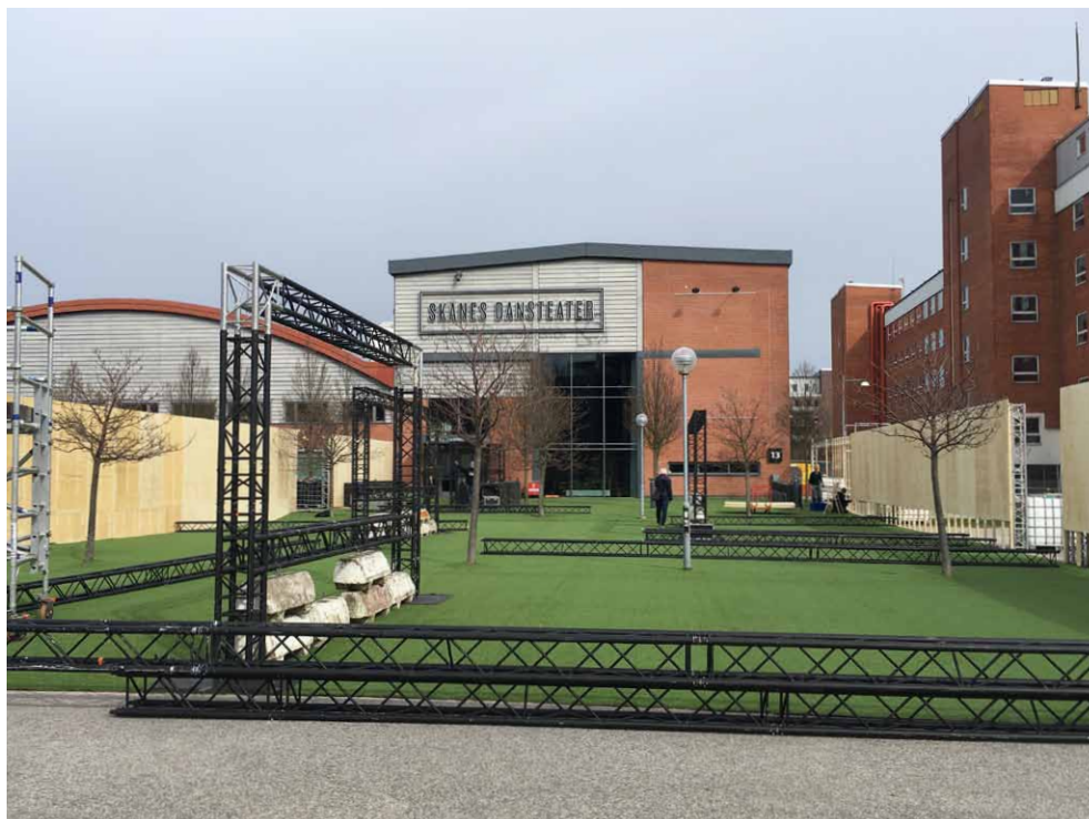
Figur 34. Trädgården 2017-04-06. Här är alla ytterväggar, och konstgräset, på plats. I bild syns även delar av innerväggarnas konstruktion av betongsuggor och metalltross.
