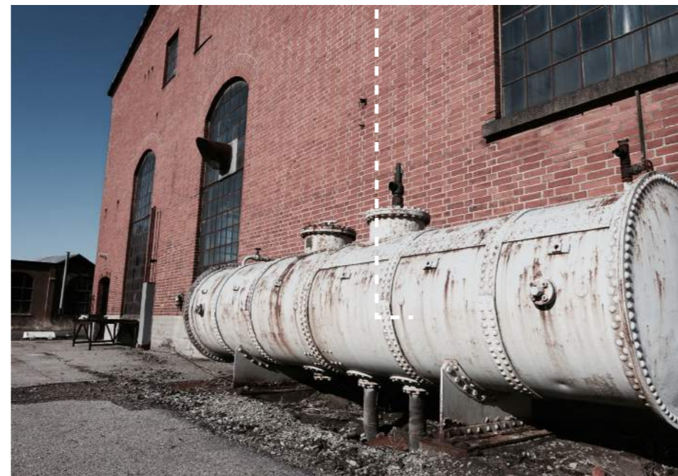
Figur 42. En rostig tank intill värmecentralen.
