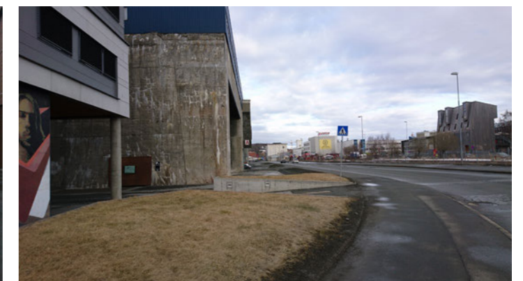
Storskaliga och slitna fassader.
