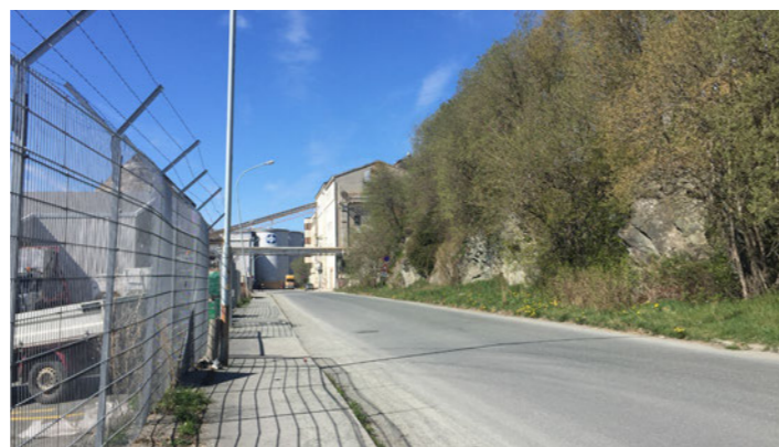
Vy mot betongfabriken.
