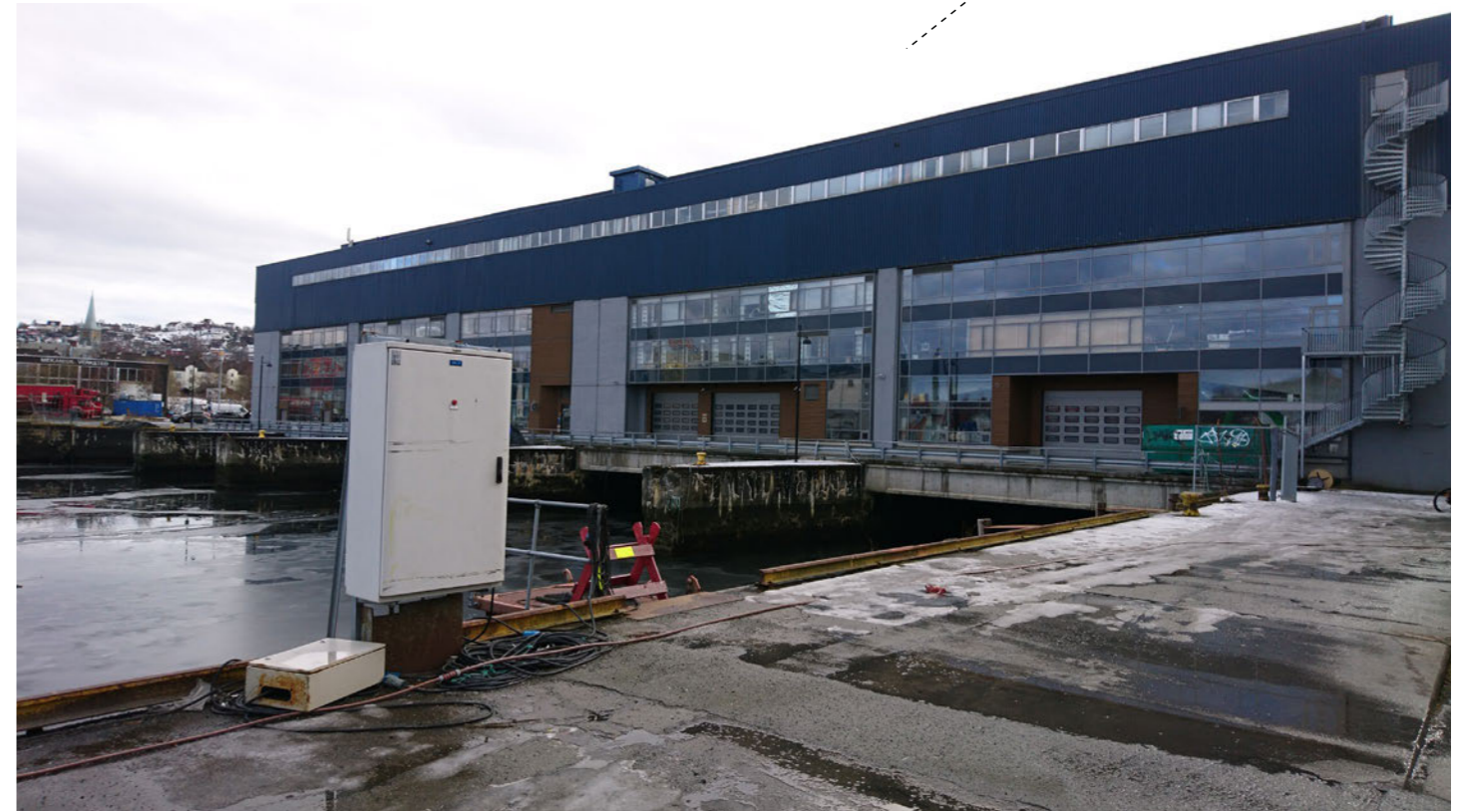
Ubåtsinfart till kulturminnesskyddad byggnad.
