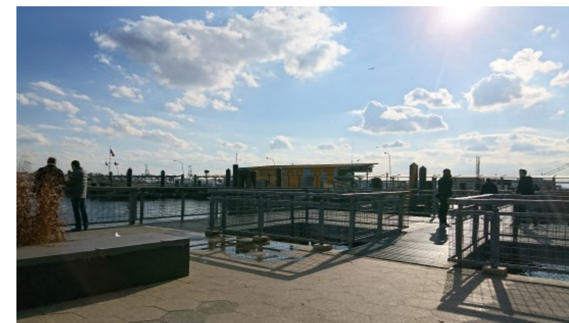
Gångväg av metallgaller där vattnet kan röra sig fritt vid högt vattenstånd.
