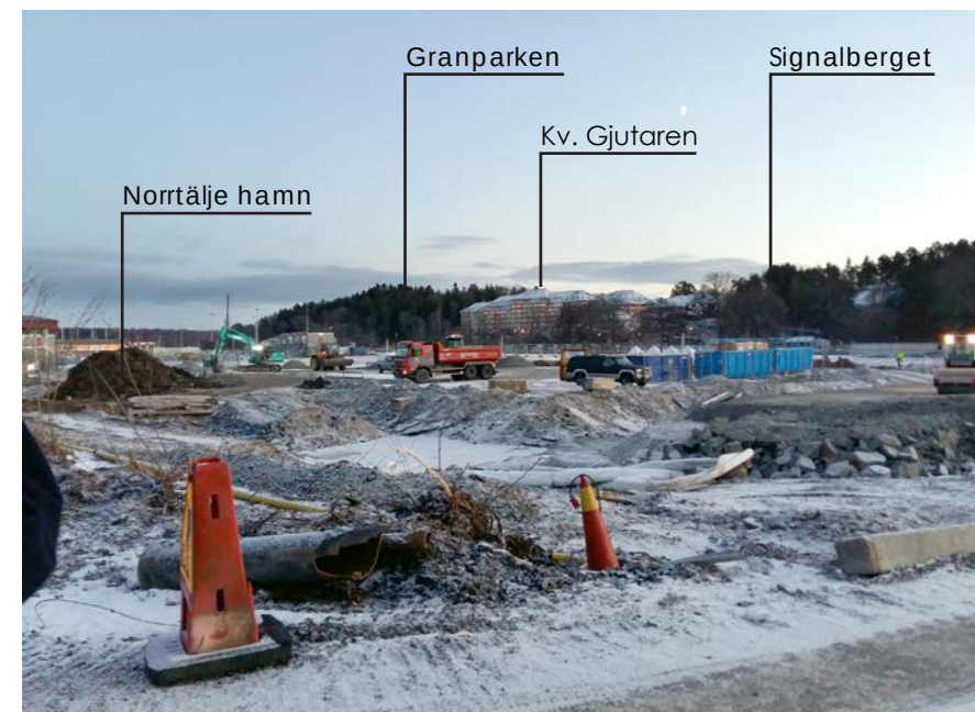
Bild 5. Hamnen som den byggarbetsplats det är just nu. I bakgrunden syns Signalberget till höger i bild, sedan Kv. Gjutaren och Granparken till vänster.
