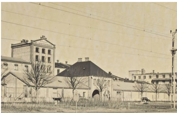
Spritfabriken någon gång under sent 1930-tal. Till höger i bild ses arbetet med tillbyggnationen inför sammanslagningen 1939. Källa: Fleninge Hembygdsförening
