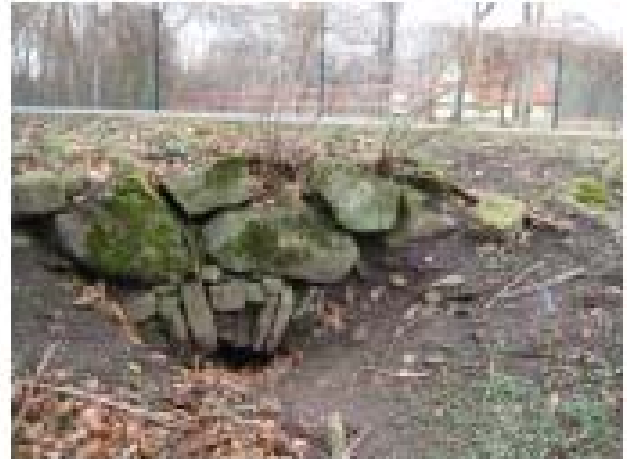
Figur 123. Stensättning vid bro och dike. Nummer 23 på listan, sida 103.
