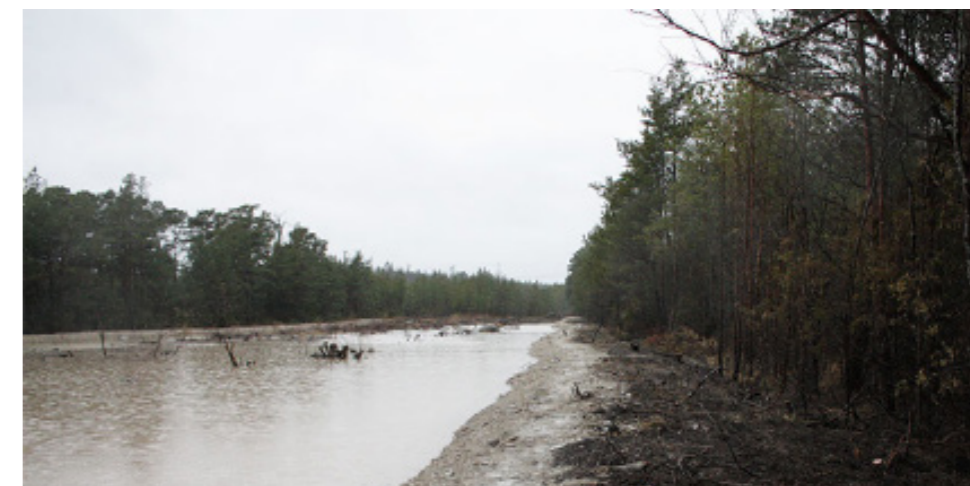
Utmed dammen i gäddfabriken finns skyddsvallar. De är leriga och kantas av sly.
