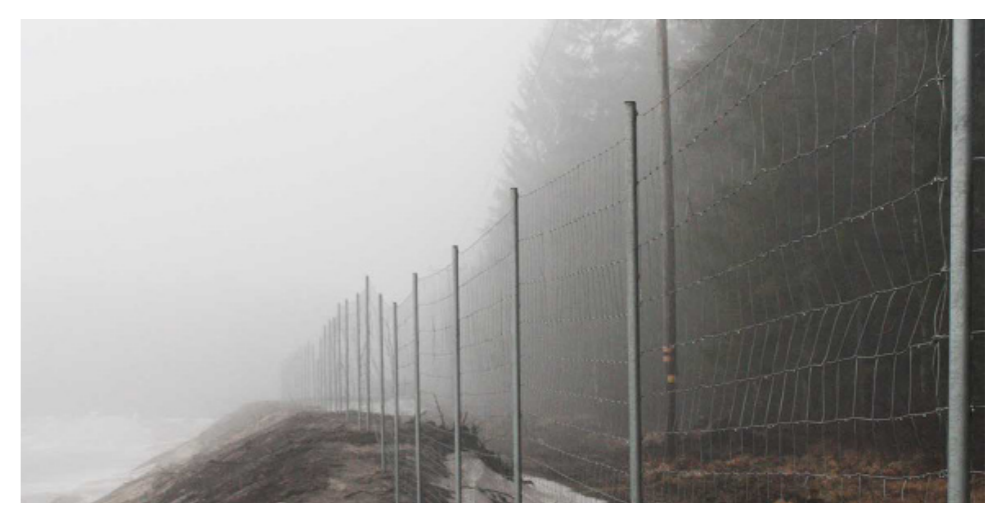
Ett viltstängsel inhägnar hela Västra brottet.
