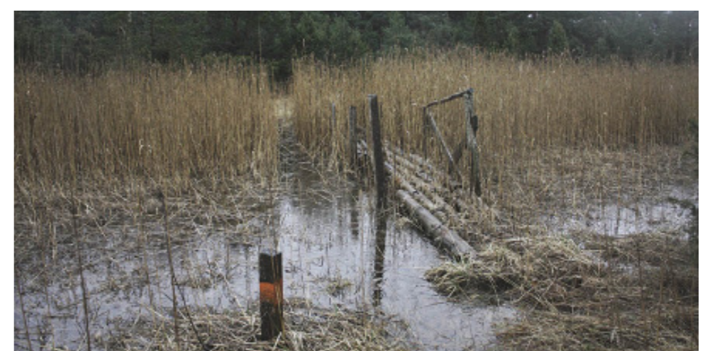
Utmed stigarna finns flera spänger. De är murkna, överväxta av vass och går inte att använda.
