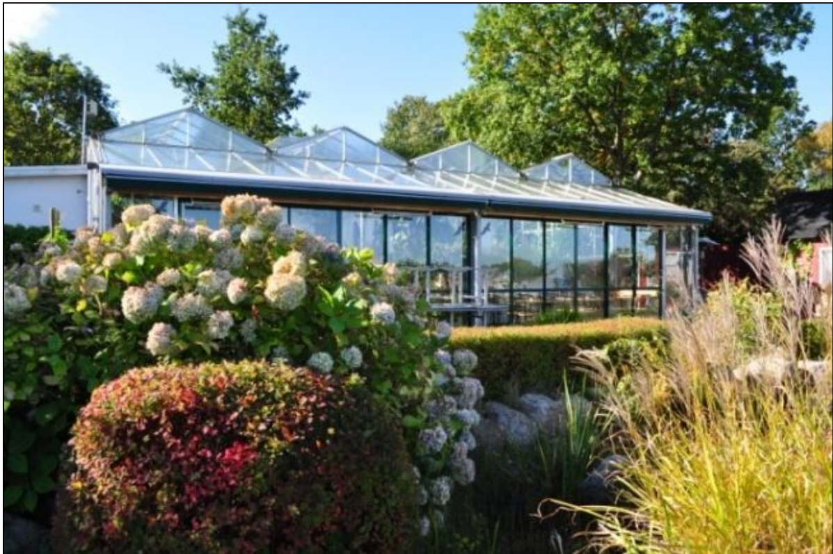
Figur 27. Växthuset byggdes 1995 och då kom även dammen till. (Foto. Ann Richardsson 2010-09-29)
