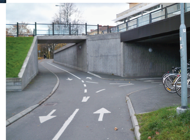
Skyddsräcken med plexiglas över gång- och cykeltunnlar är en bra lösning ur trygghetsperspektiv eftersom det blir ljusare i tunnelarna och med insikt för de bilar som passerar ovanför. foto: Anton Svensson, 28/10-09
