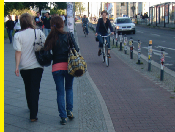
Ofta är cykelbanorna skilda från vägbanan med exempelvis pollare, här ses röd betongstensbeläggning som ibland kan vara svår att cykla på foto: Anton Svensson 13/6-09
