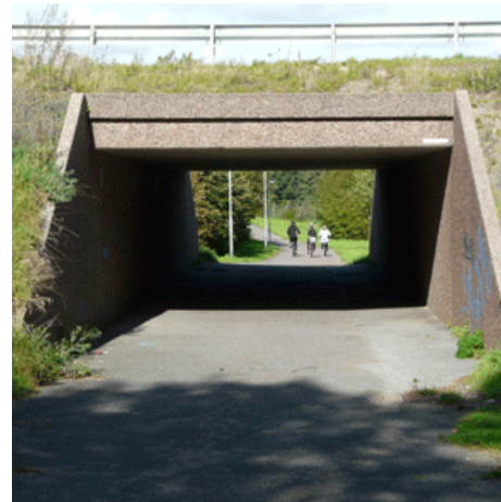
Gångtunnel in till området.
