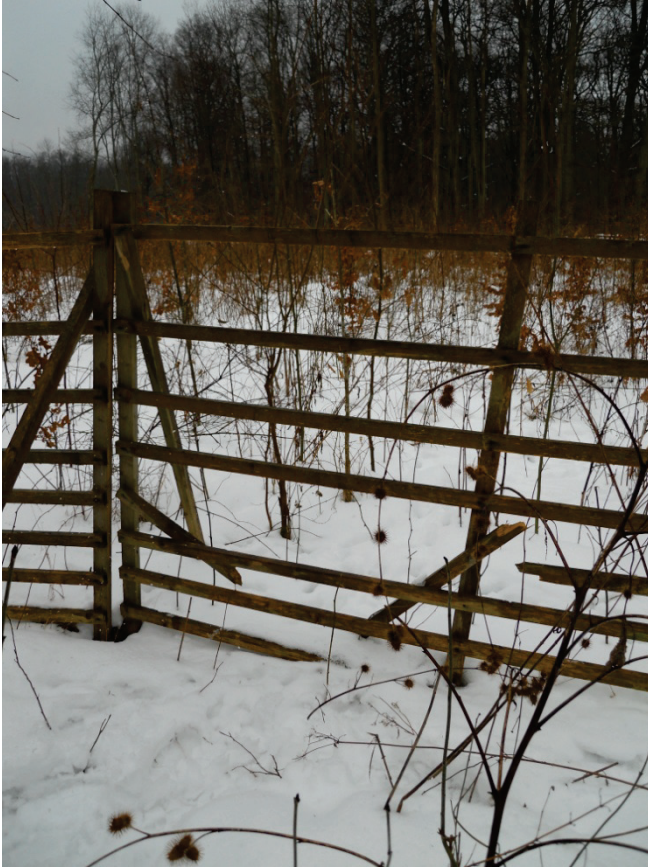
Eget foto. Hägn byggt 2006, Vildsvinsskada.
