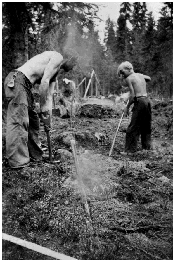
Figur 40. Fadern Villihad Skoglund och sonen Johan anlägger en cykelstig mellan byarna Grundsjö och Berg i Bodums socken, Ångermanland . Cykelstigsbyggnationen skedde på kronotorparen Viktor Lövs initiativ. Senare breddades den till bilväg. Fotot är taget år 1938 av okänd fotograf. Fotografiet tillhör Jämtlis bildarkiv och används med tillstånd.
