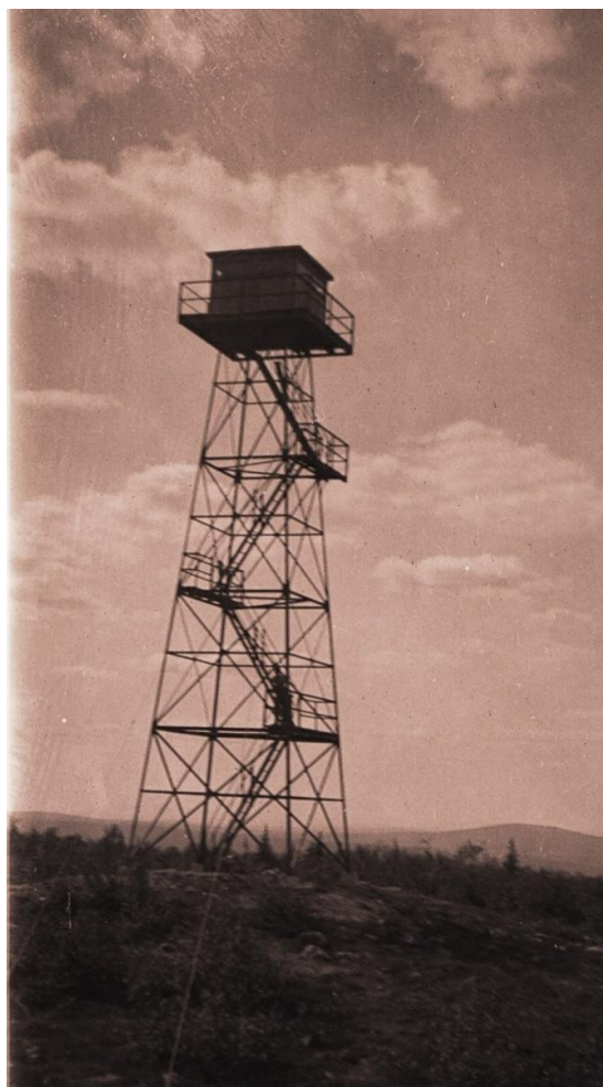
Figur 42. Brandtorn nummer 7 beläget på berget Ananasse där Harry arbetade under sommaren 1942. Fotot tillhör Harry Andersson.
